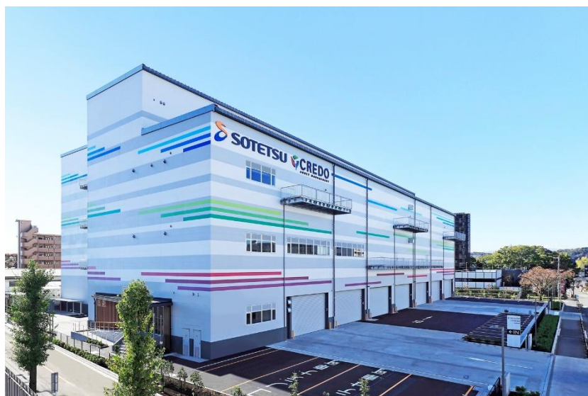
「CREDO 羽村」の外観
