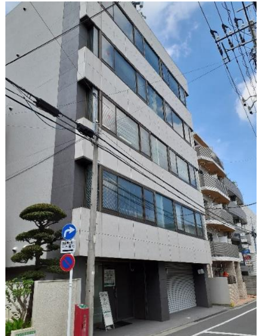
「都立大学駅前ビル」外観
