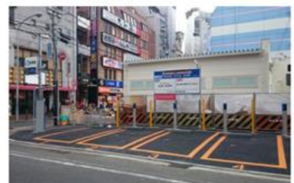
施設内に新設した駐車場
